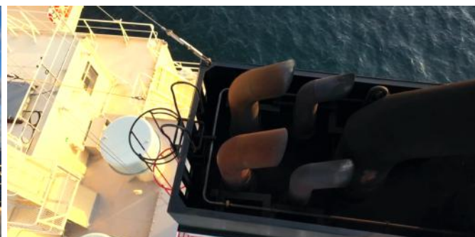
写真8：ドローンによる上空からのファンネル上部点検
