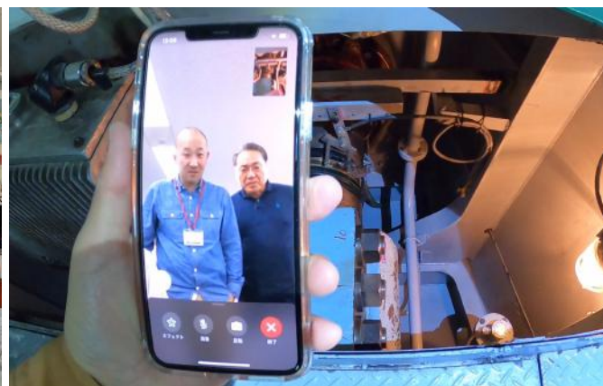
写真6：機関室最下層と陸上間のリアルタイムビデオ通信
